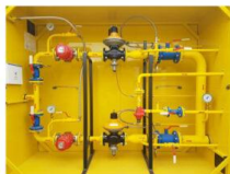
ГРПШ-МОДУЛЬ-А50-2030-У1, оснащенный фильтрами газа РЕД-50.
